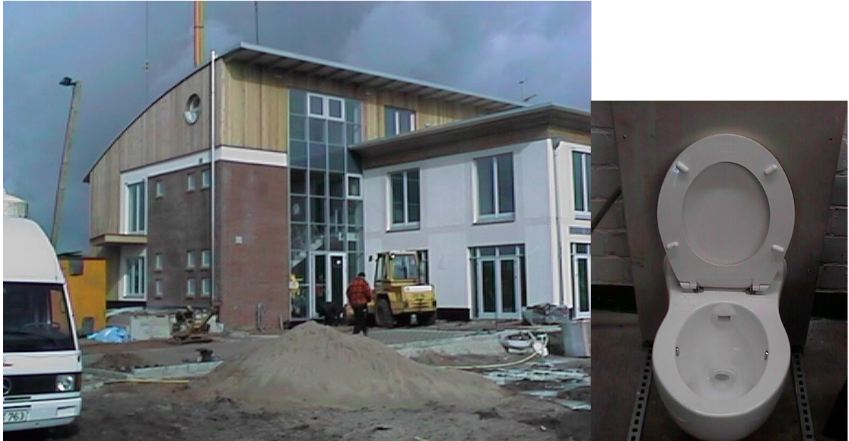
Abbildung 4: Das Gemeinschaftshaus der für 350 Bewohner konzipierten Wohnsiedlung „Flintenbreite“ mit der Vakuumpumpstation, der Biogasanlage und der Anlage zur Wärme- und Energiegewinnung. Detailbild: Vakuumtoilette mit einem Spülwasserverbrauch von ca. 1 Liter.
